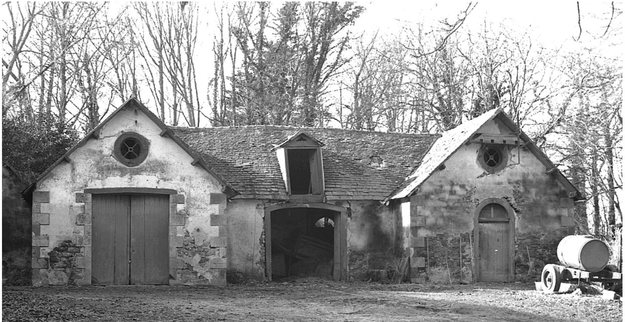
Communs, état en 1979, aile est, vue générale
