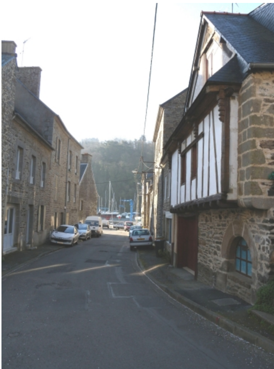
Vue de la rue donnant sur le port, avec ses maisons traditionnelles
