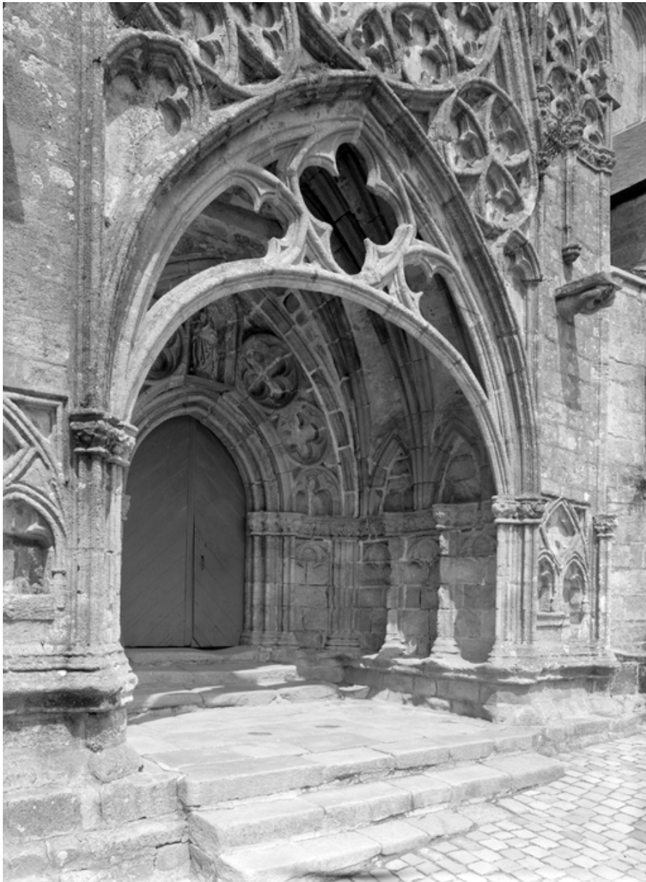
Porche sud, vue sud-ouest
