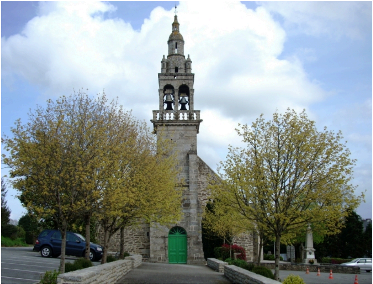
Landeleau, église paroissiale Saint-Théleau : élévation ouest
