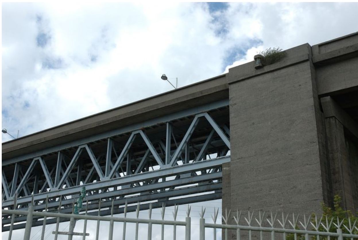
Vue du pont routier de l'Harteloire construit de 1948 à 1951 : pont en poutre en treillis, treillis type Warren
