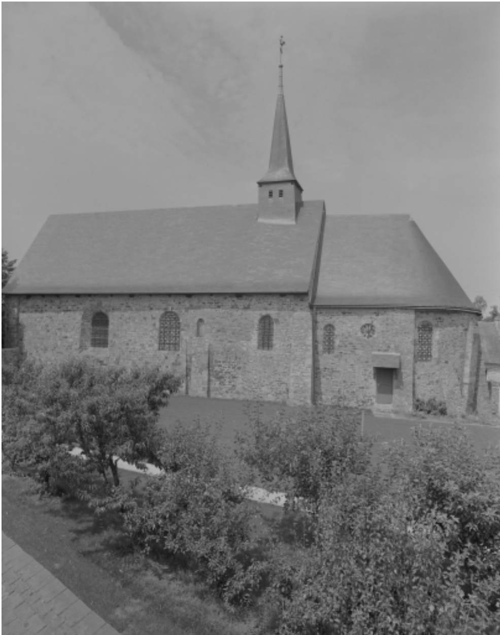
Elévation sud : vue générale
