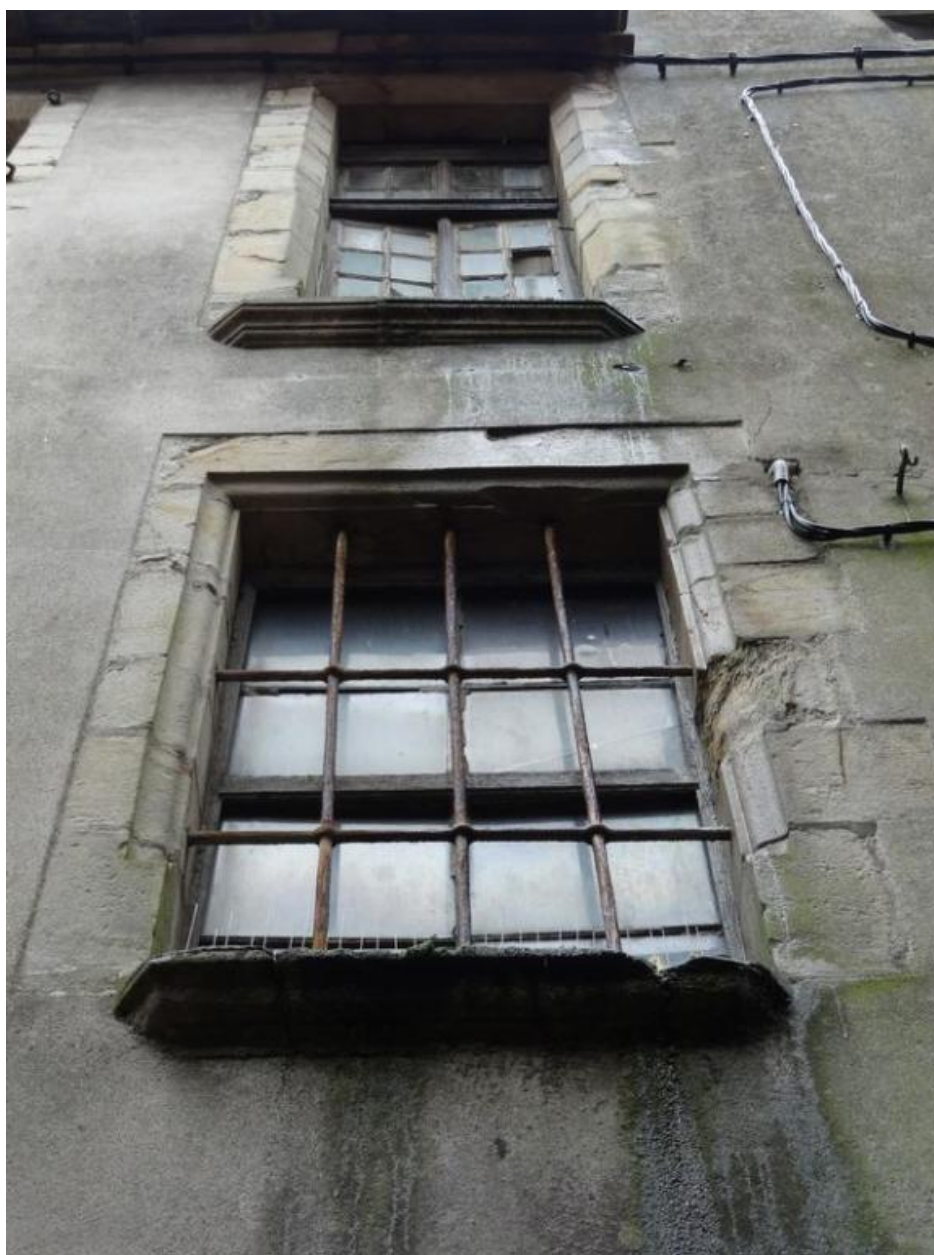
Fenêtre du rez-de-chaussée de la façade ouest
