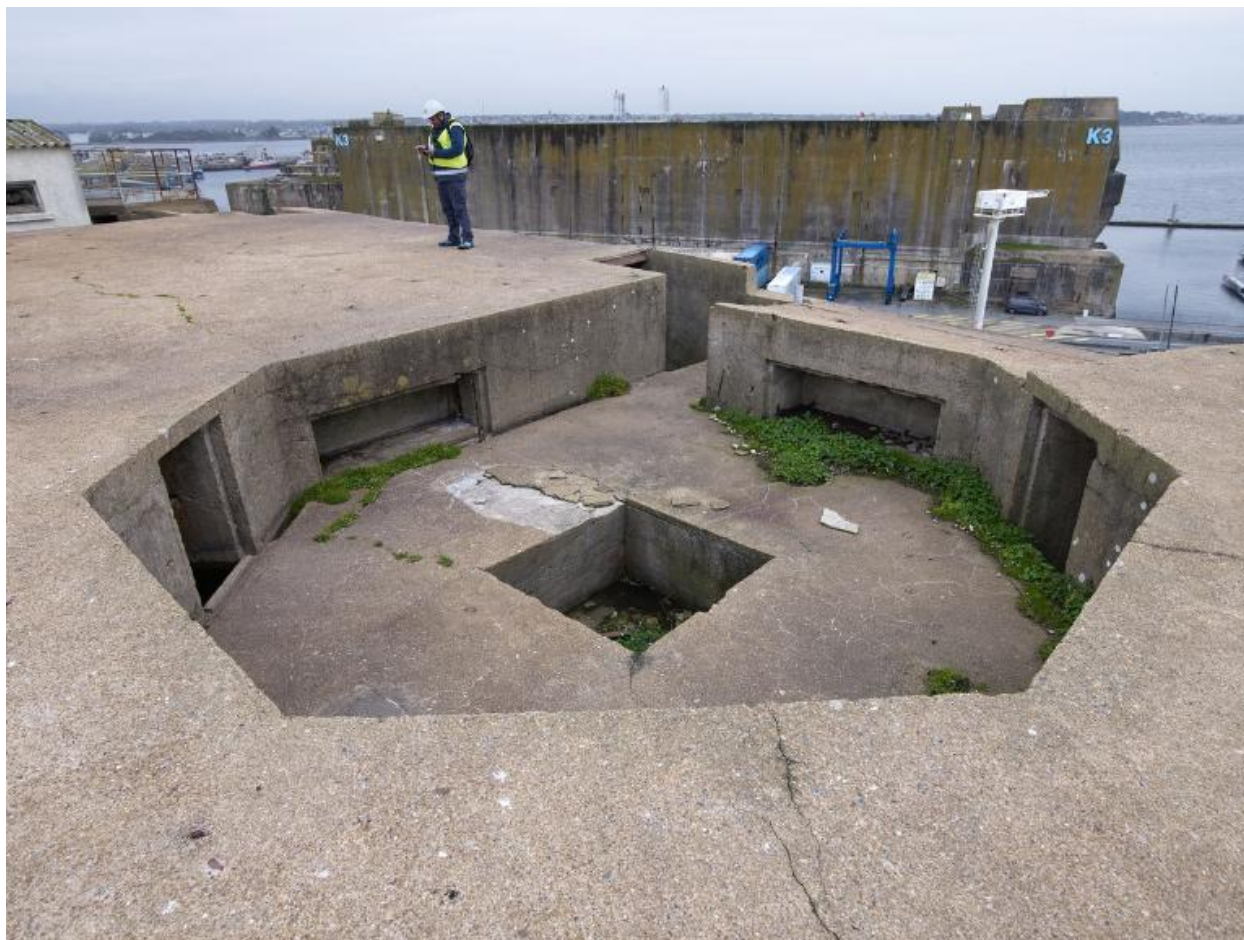
Vue de la cuve ouest pour canon. Au centre, l'emplacement pour le canon ; autour, niches à munition et petits abris pour les soldats. En arrière-plan, le bunker KIII
