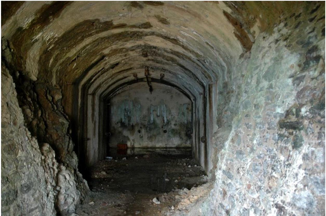
Vue de l'une des deux chambres de tir depuis l'embrasure (état en 2005)
