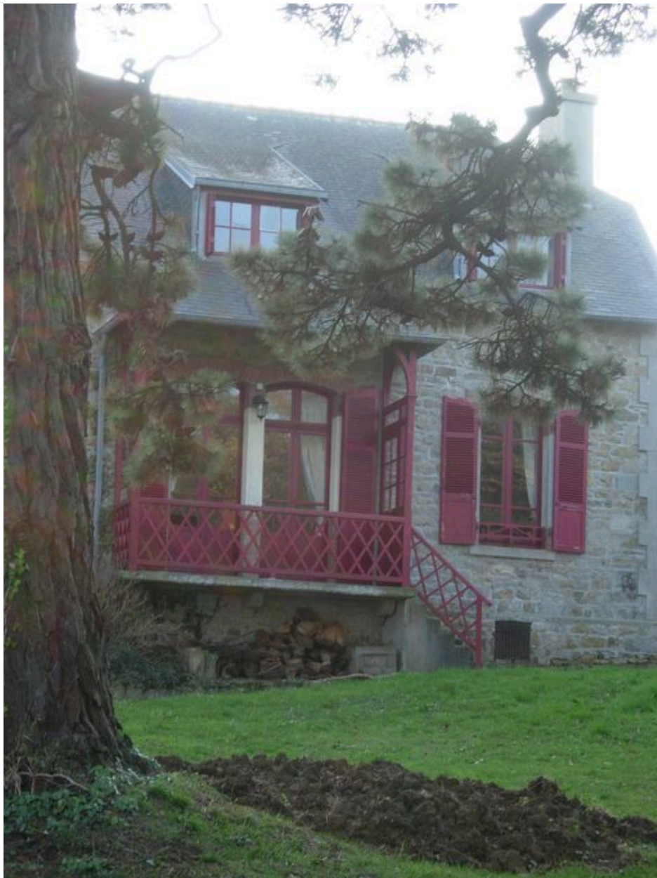
Vue générale de la Villa Le Joncour
