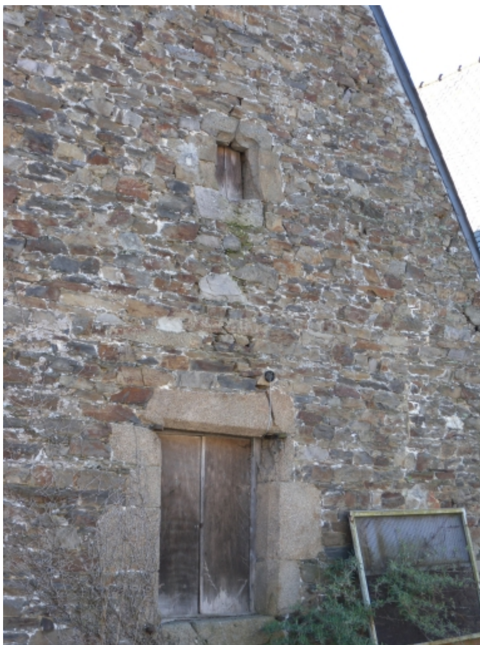
Vue des ouvertures de la façade postérieure d'anciens entrepôts du Légué, daté du 15ème ou 16ème siècle
