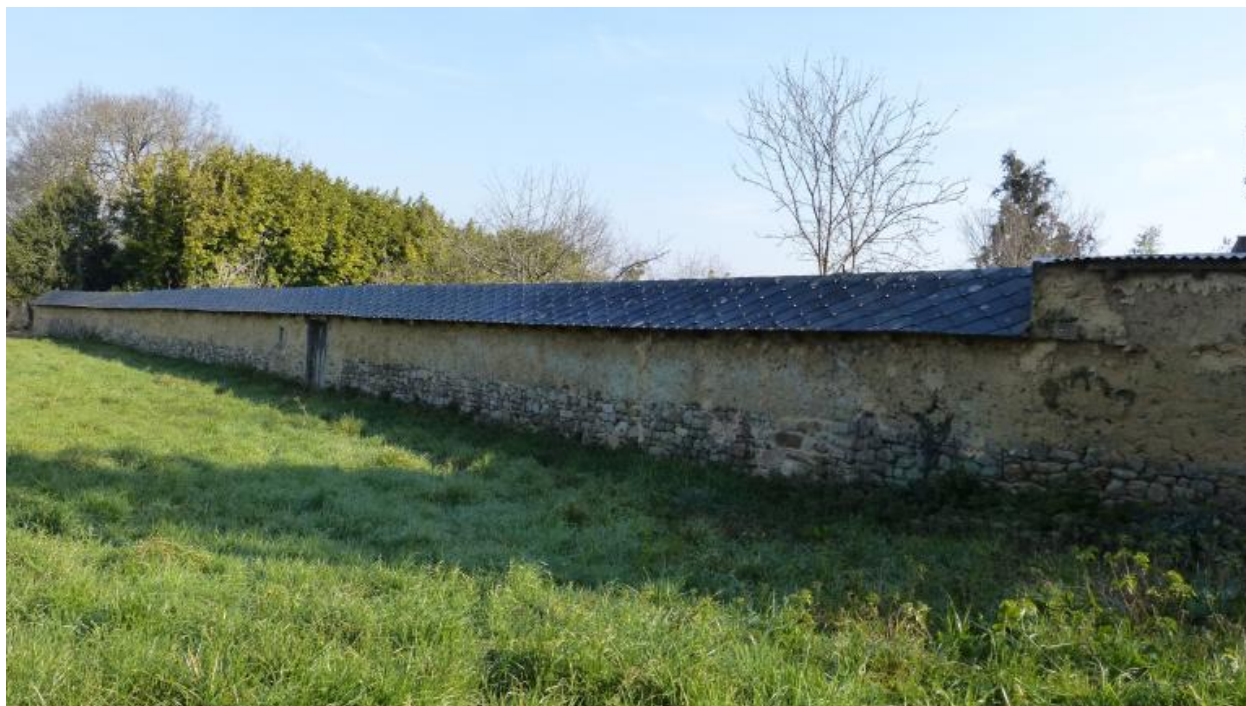
Détails du mur de clôture, rue de l'église Saint-Ouen
