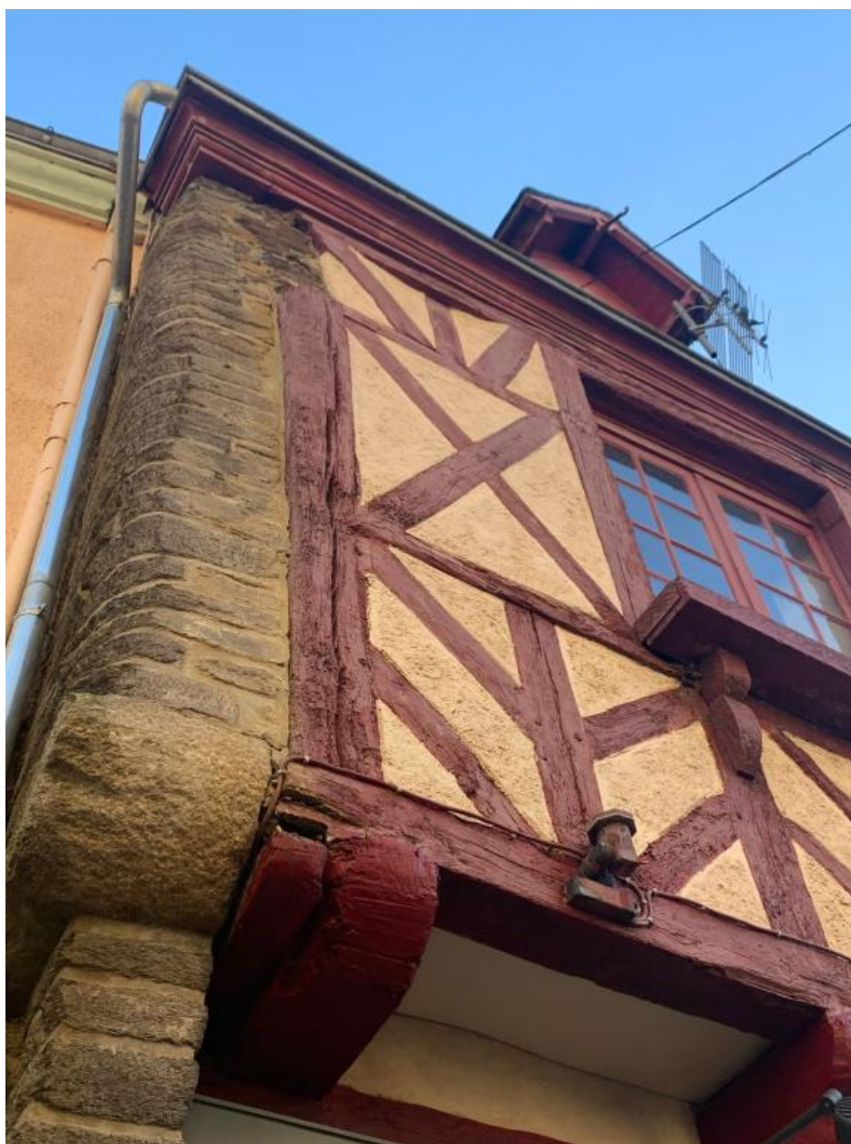
Elévation nord-ouest, vue de l'encorbellement
