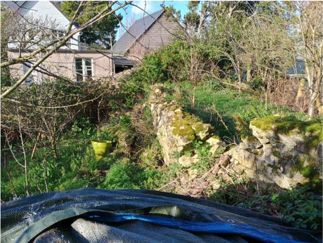
Vue des vestiges de la digue dans la parcelle section CA, n° 558 depuis la parcelle CA, n° 557
