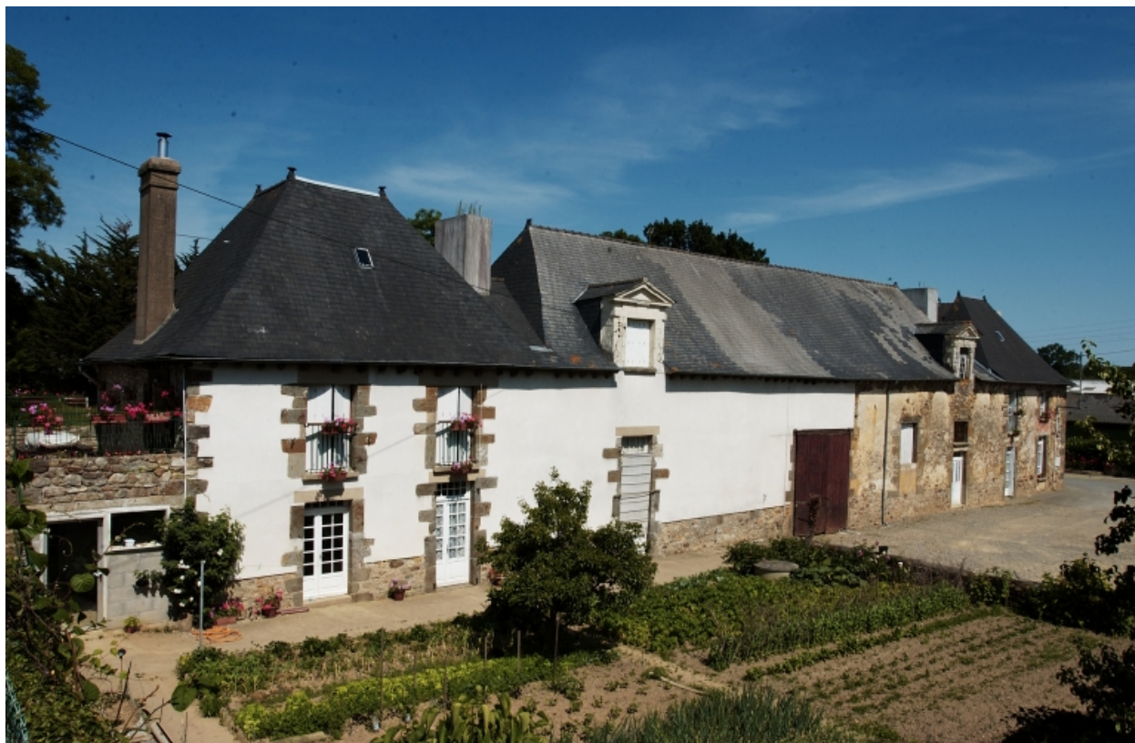
Façade postérieure des remises
