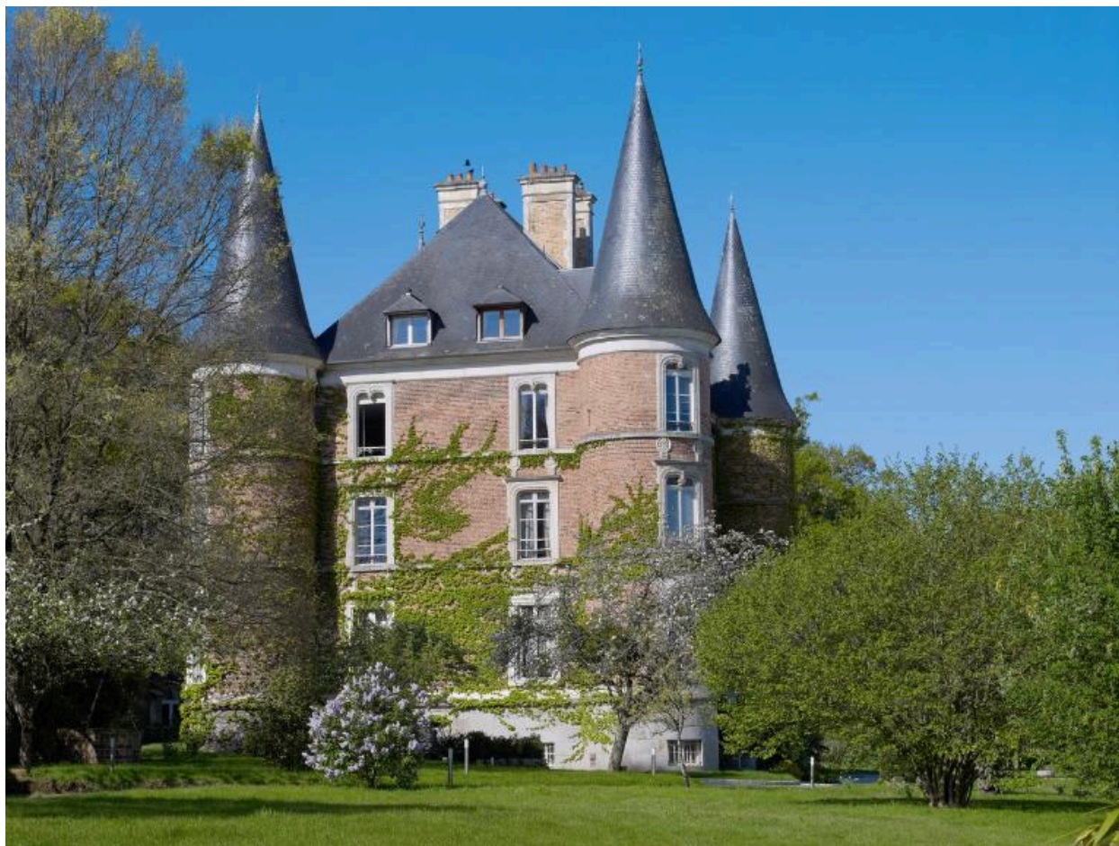
Vue générale façade est
