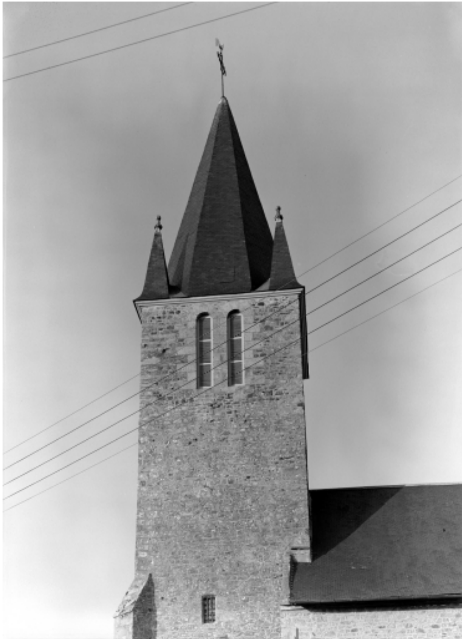
Elévation sud, clocher, partie haute : vue générale
