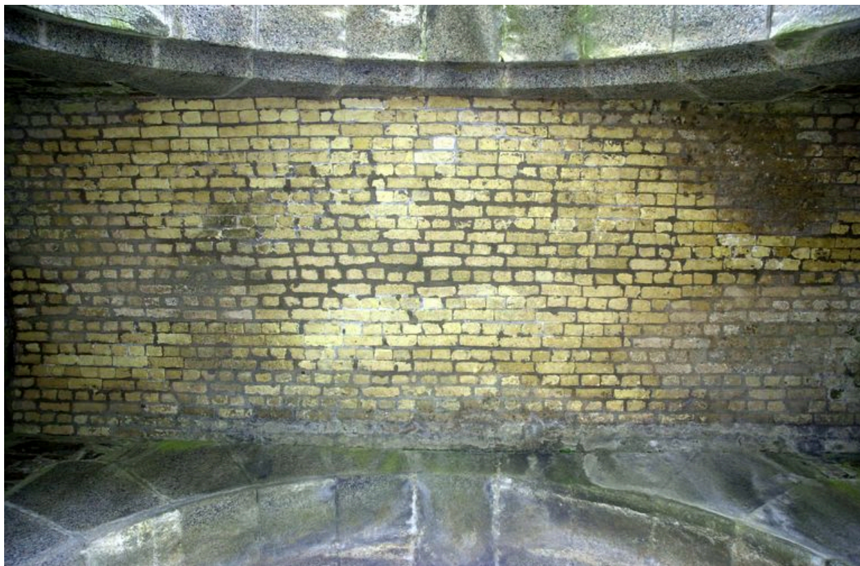
Vue de la voûte du passage d'entrée (état en 2007)
