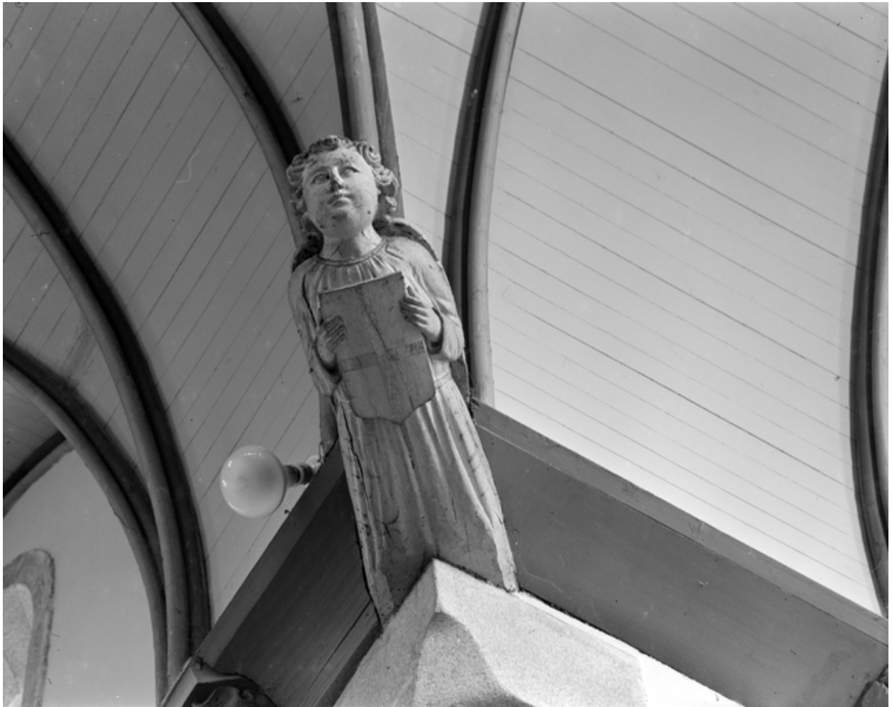
Châteaulin, église paroissiale Saint-Idunet : blochet, croisée, angle sud-ouest, état en 1972
