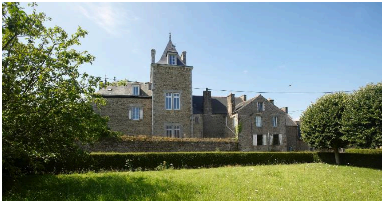
Vue générale arrière
