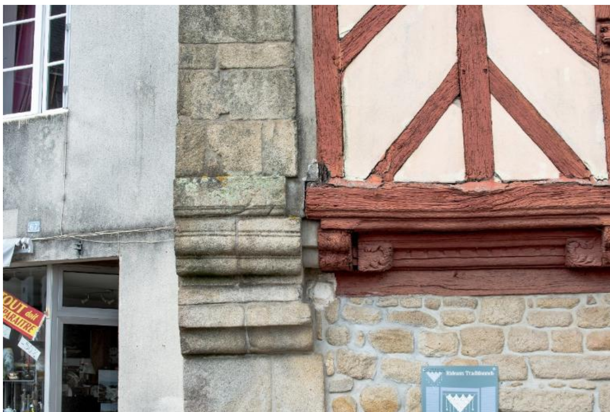
Articulation entre pan de bois et maçonnerie.
