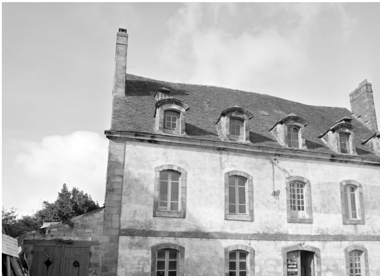
Elévation antérieure, vue générale.
