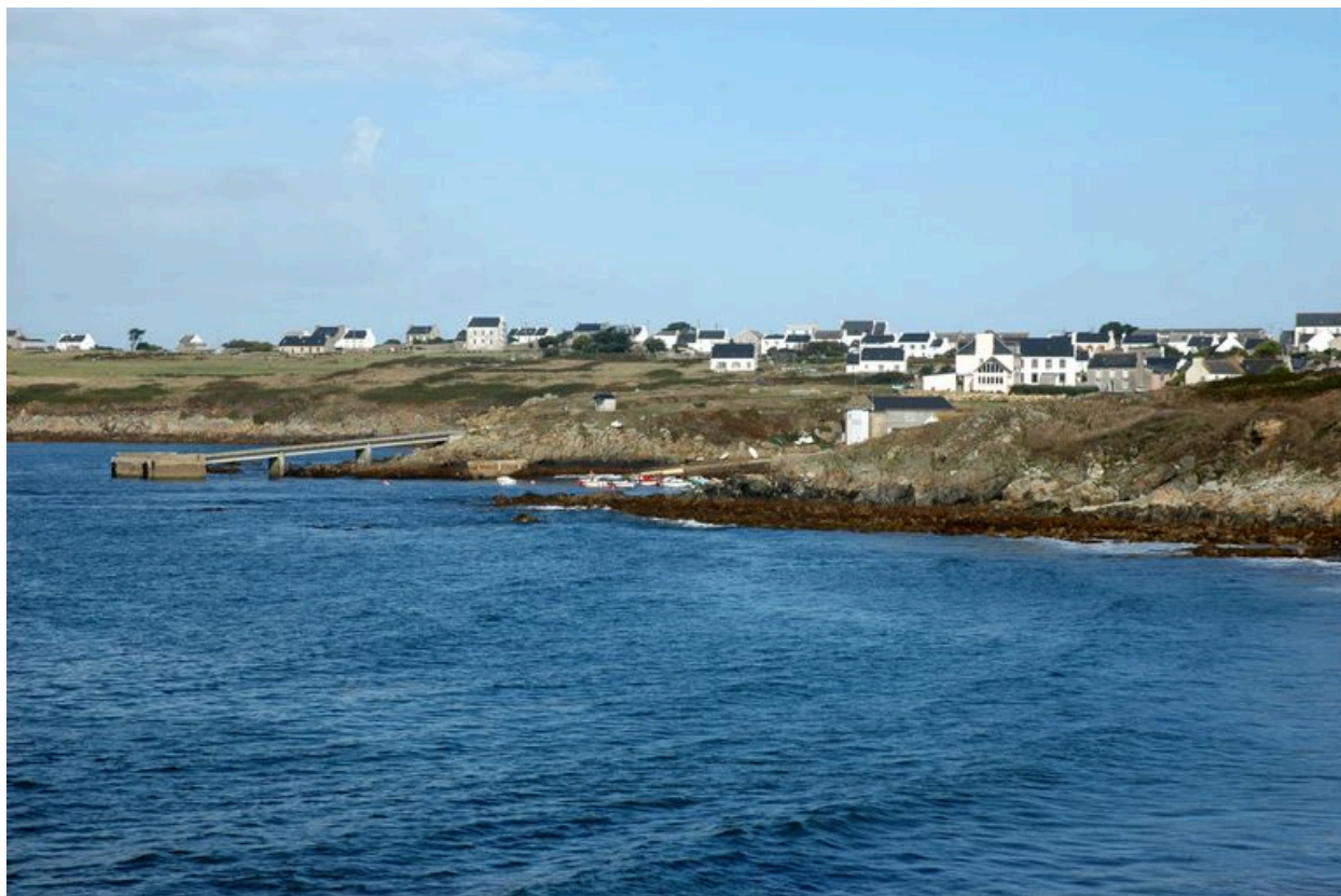
Vue du port-abri de Lampaul
