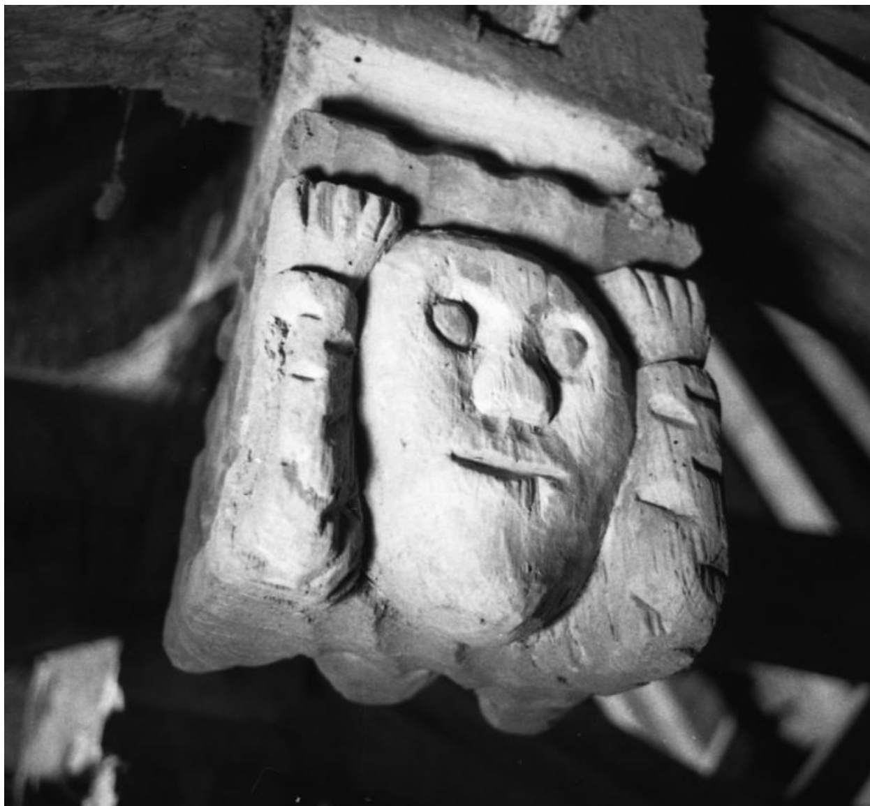
Charpente, détail de la clé 6.
