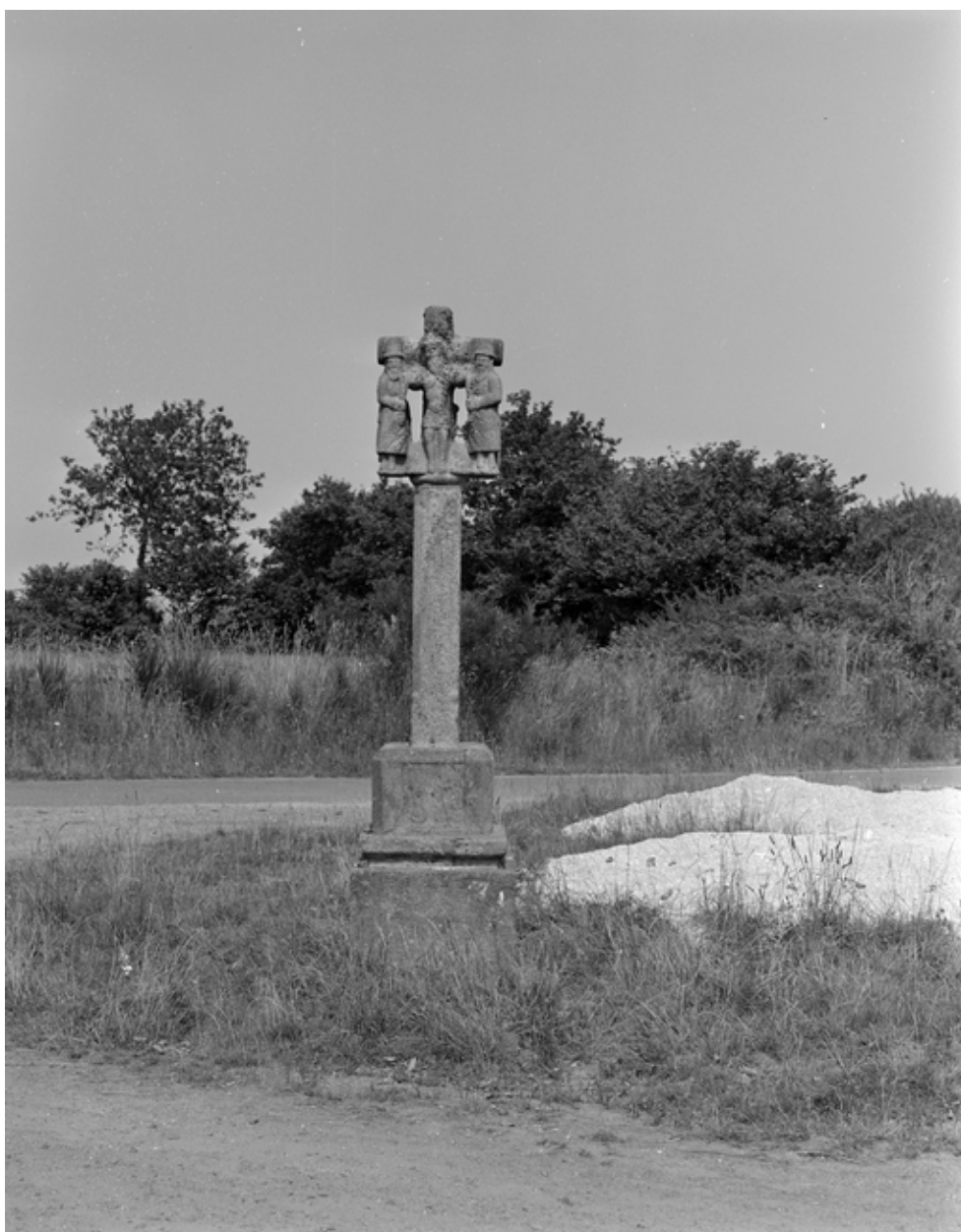
Vue générale nord
