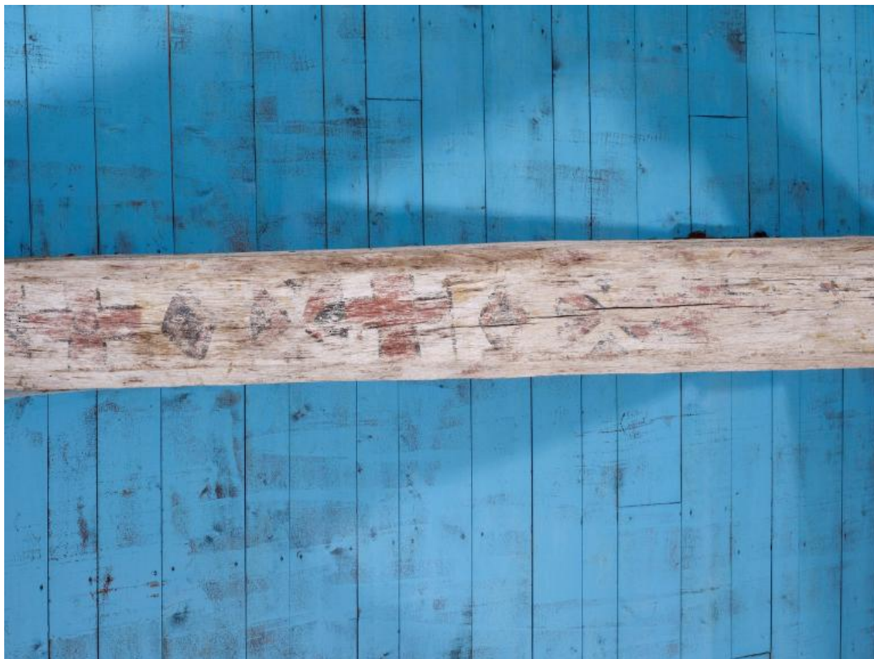
Charpente de la nef ; entrain à décor de croix, de macles et de chevrons
