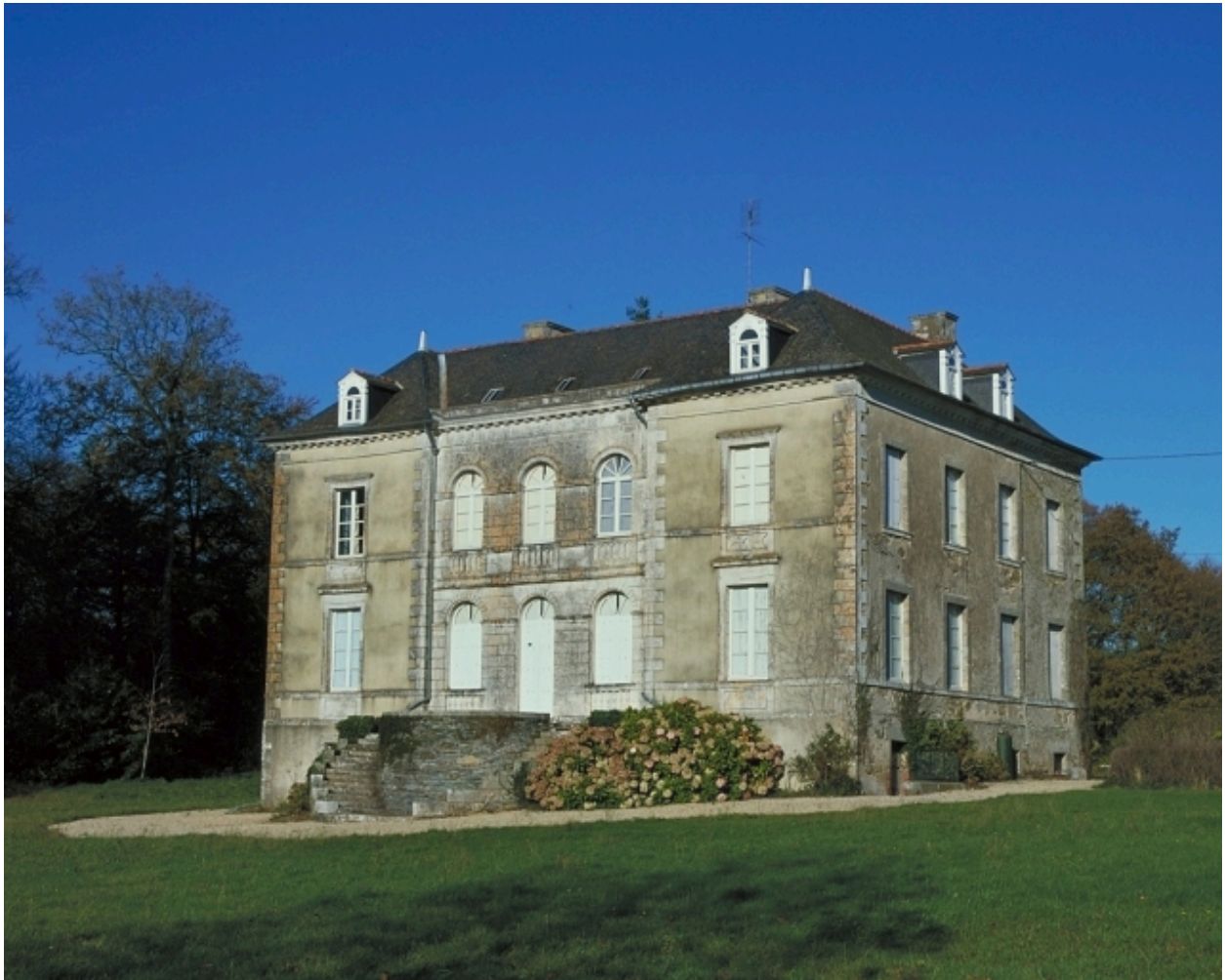
Façade postérieure : vue générale
