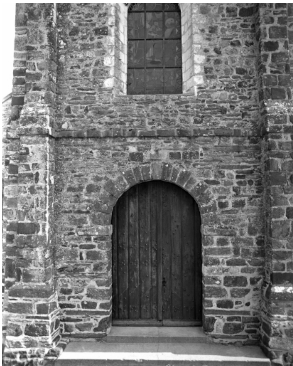
Elévation ouest, porte ; vue générale
