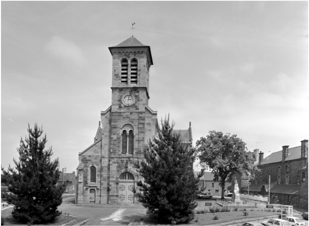
Elévation Ouest : vue générale
