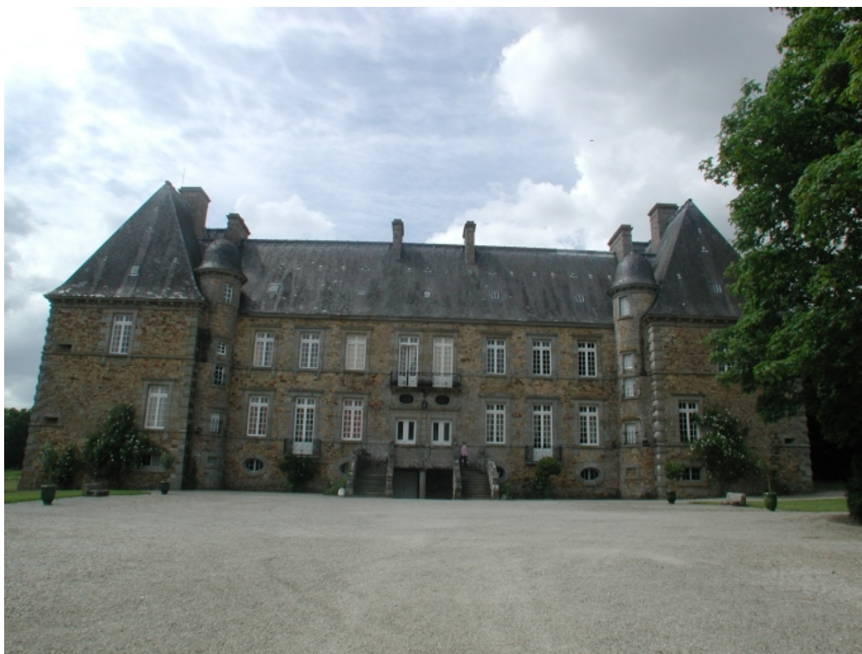
Façade est : vue générale
