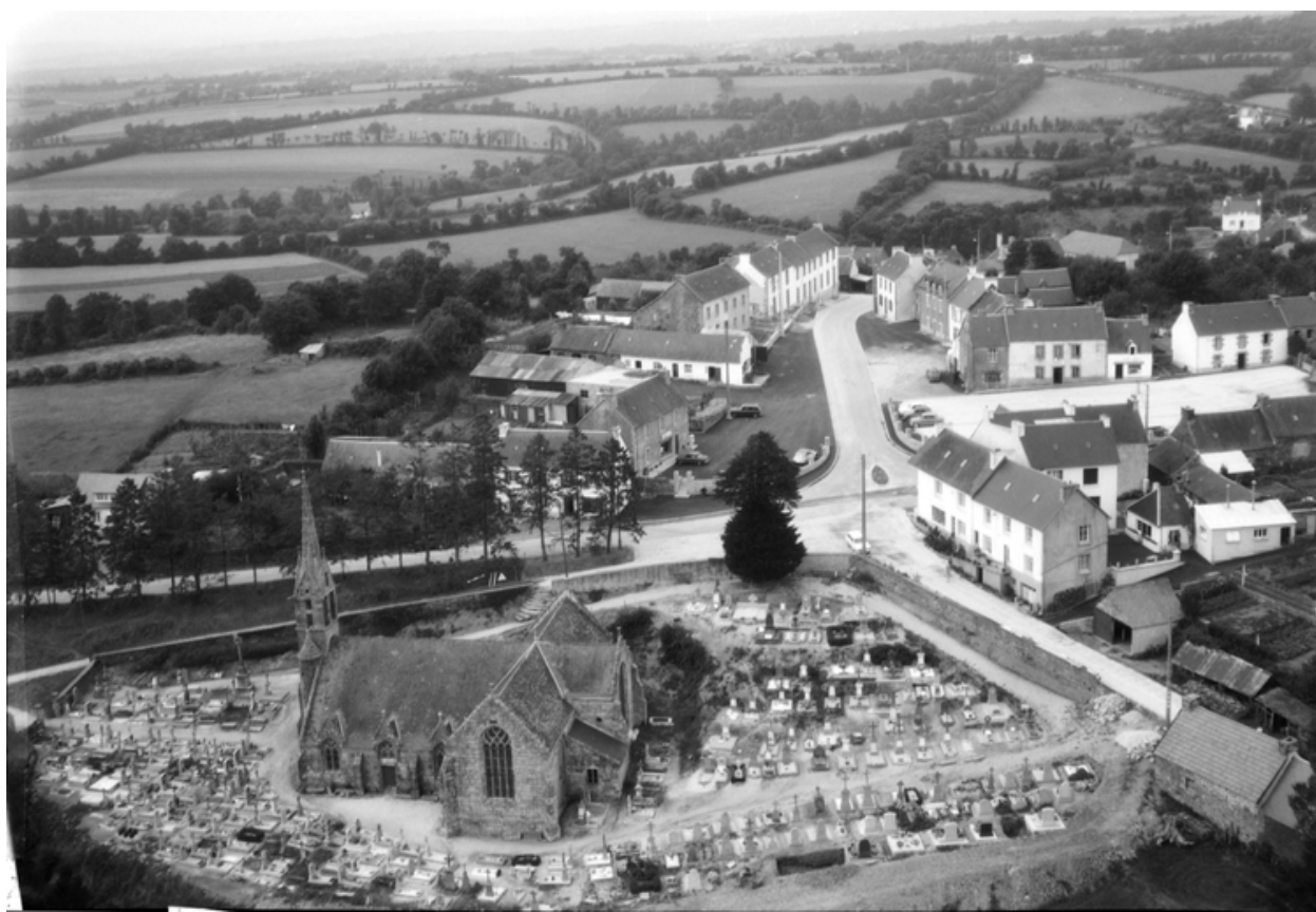
Vue aérienne sud
