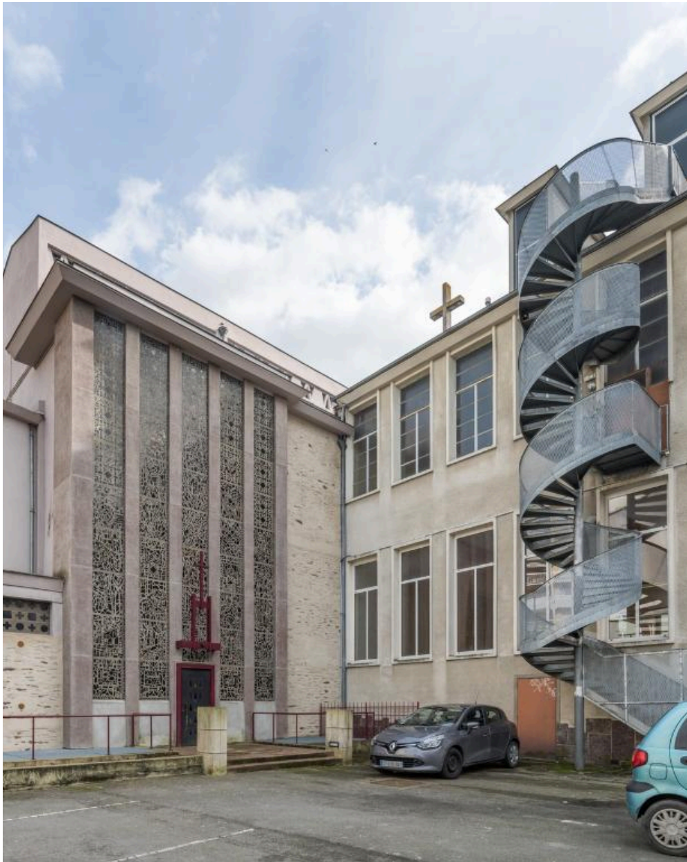
Bâtiment de 1951 et chœur de la chapelle vus du nord
