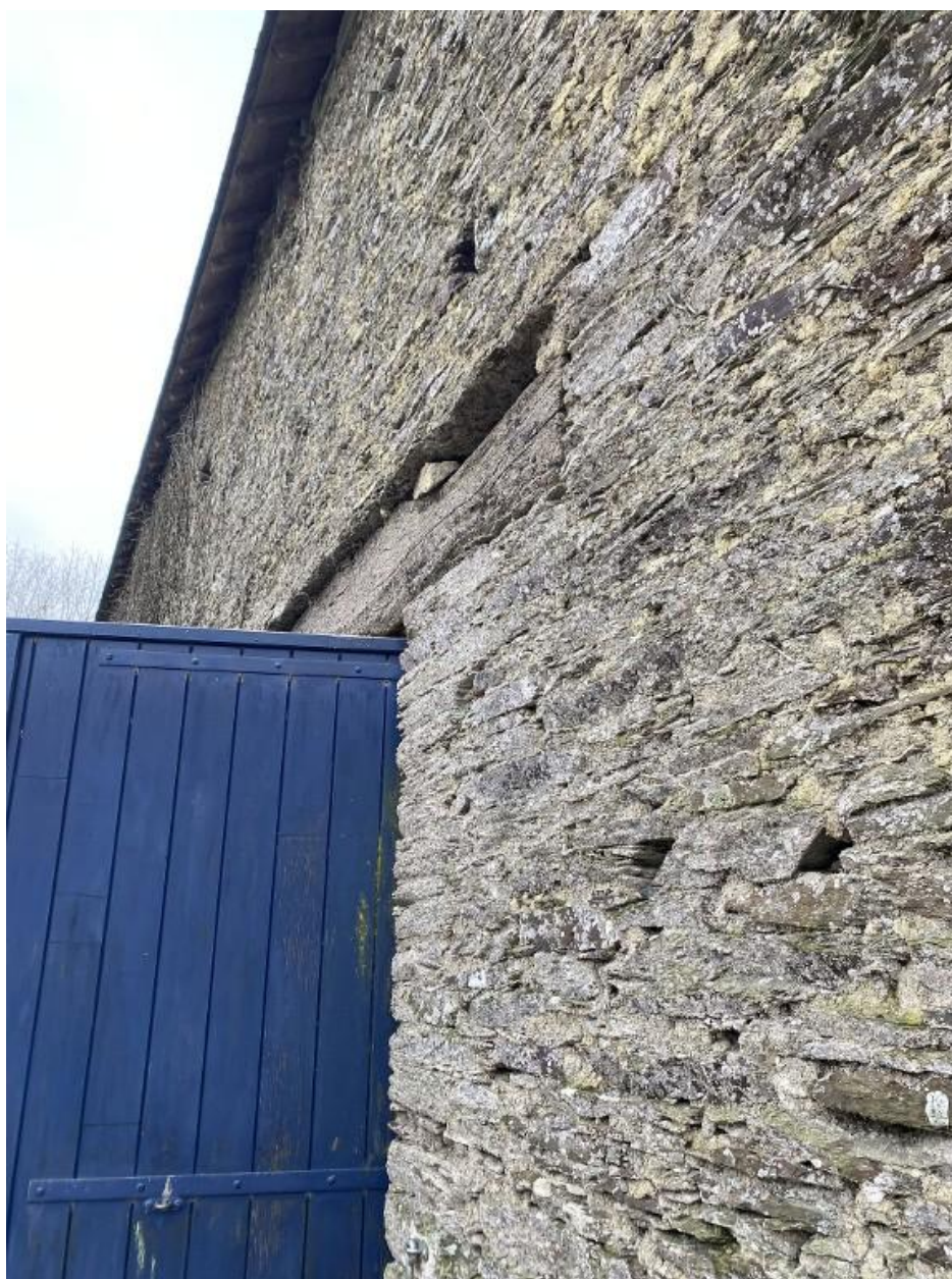
Larmier, aile nord, élévation nord
