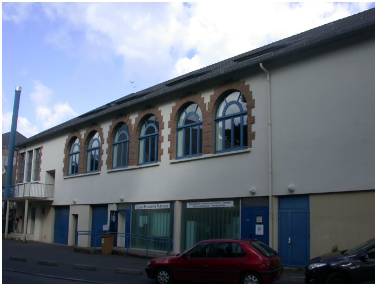
Vue de la façade postérieure
