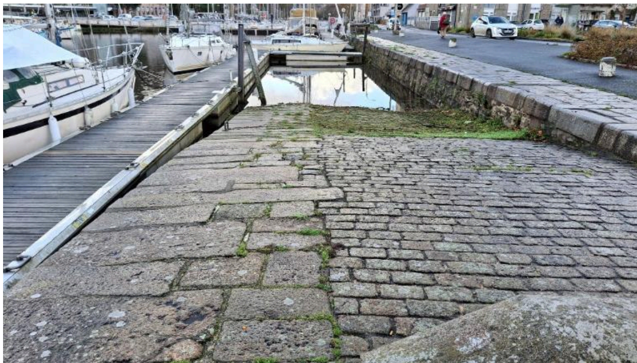
Détails de maçonnerie de la cale du quai d'Aiguillon
