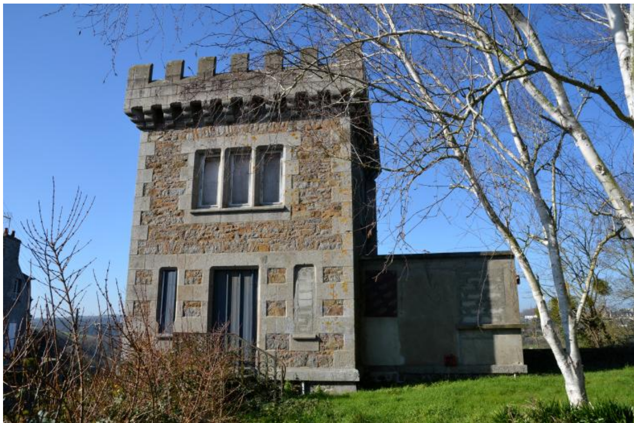
Vue de l'élévation orientée vers l'Est-sud-est
