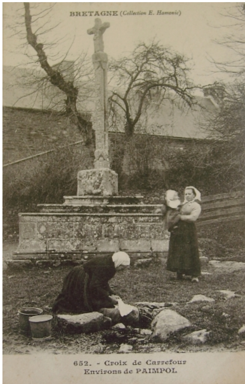
Vue générale vers 1900 (AD 22)
