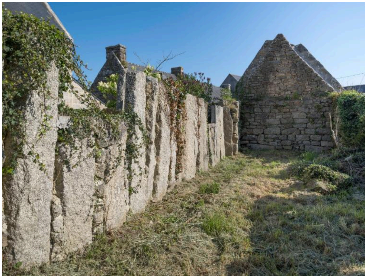
Elévation avec orthostates d'une ancienne grange.
