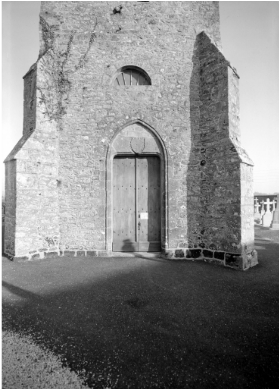
Elévation ouest, porte : vue générale
