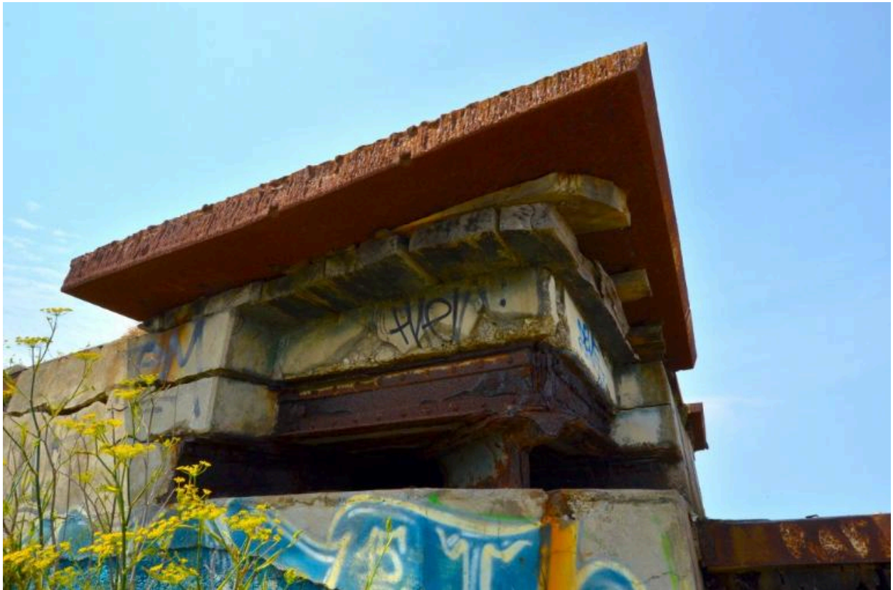
Vue du poste de direction de tir de la batterie de 138 mm de Taillefer (Le Palais, front de mer de Quiberon)
