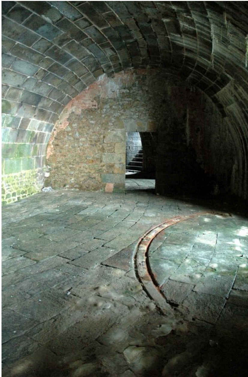
Vue du fort de la Conchée : casemate (n° 2) dit souterrain à deux embrasures
