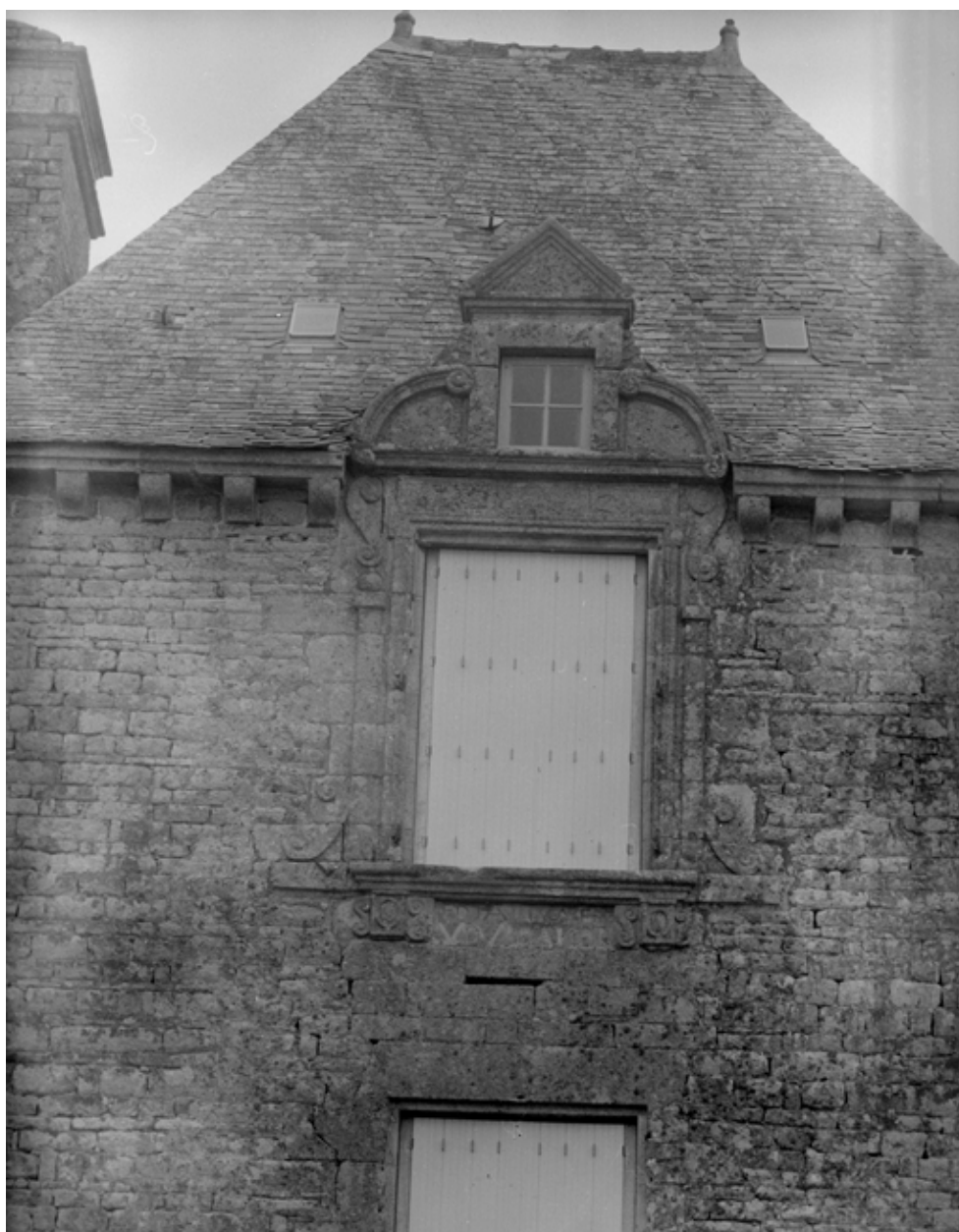
Logis, élévation postérieure, pavillon d'angle : vue des baies supérieures
