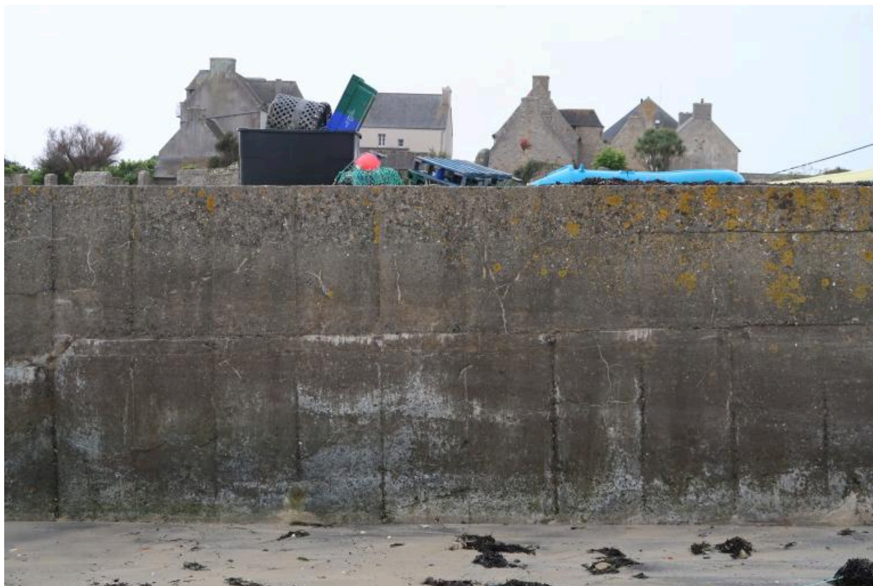
Cale de Porz Kernog, côté est, partie bétonnée construite dans les années 1970
