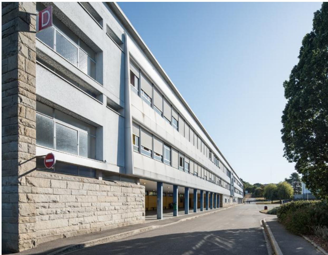
Bâtiment D, externat : vue d'ensemble prise de l'est. Louis Arretche et Jean Monge, architectes, plans 1959.
