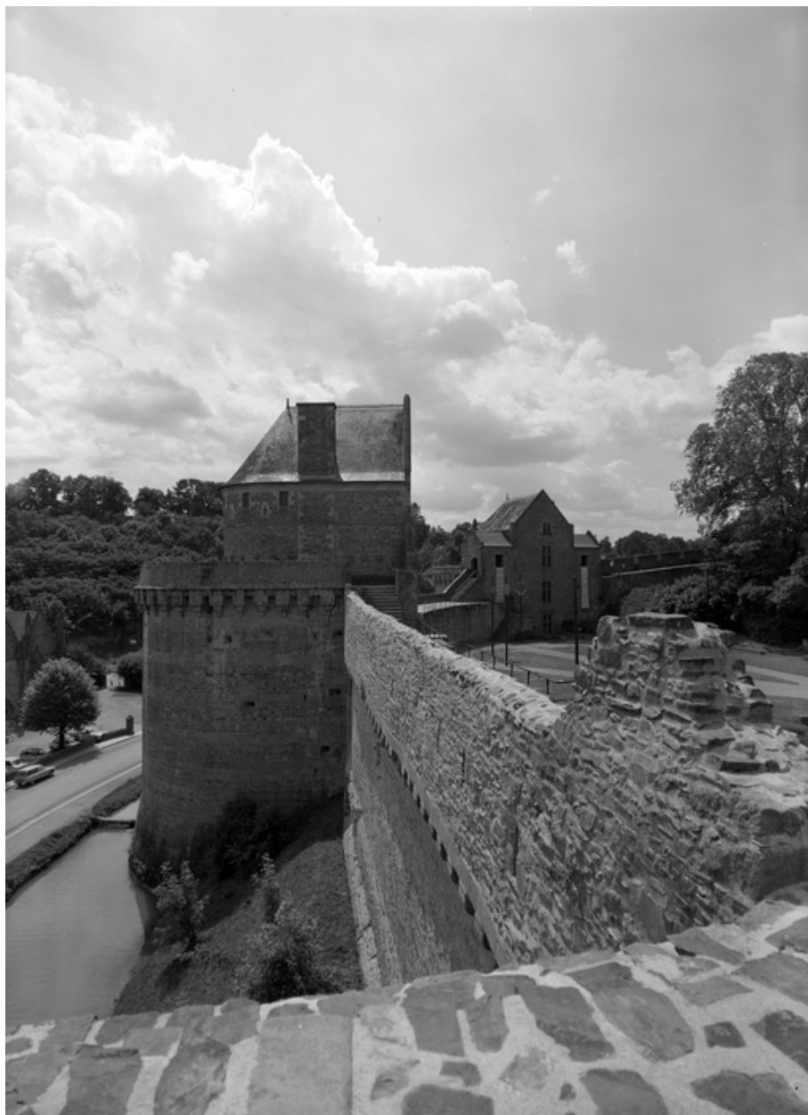
Tour sud-est Raoul, vue latérale est.
