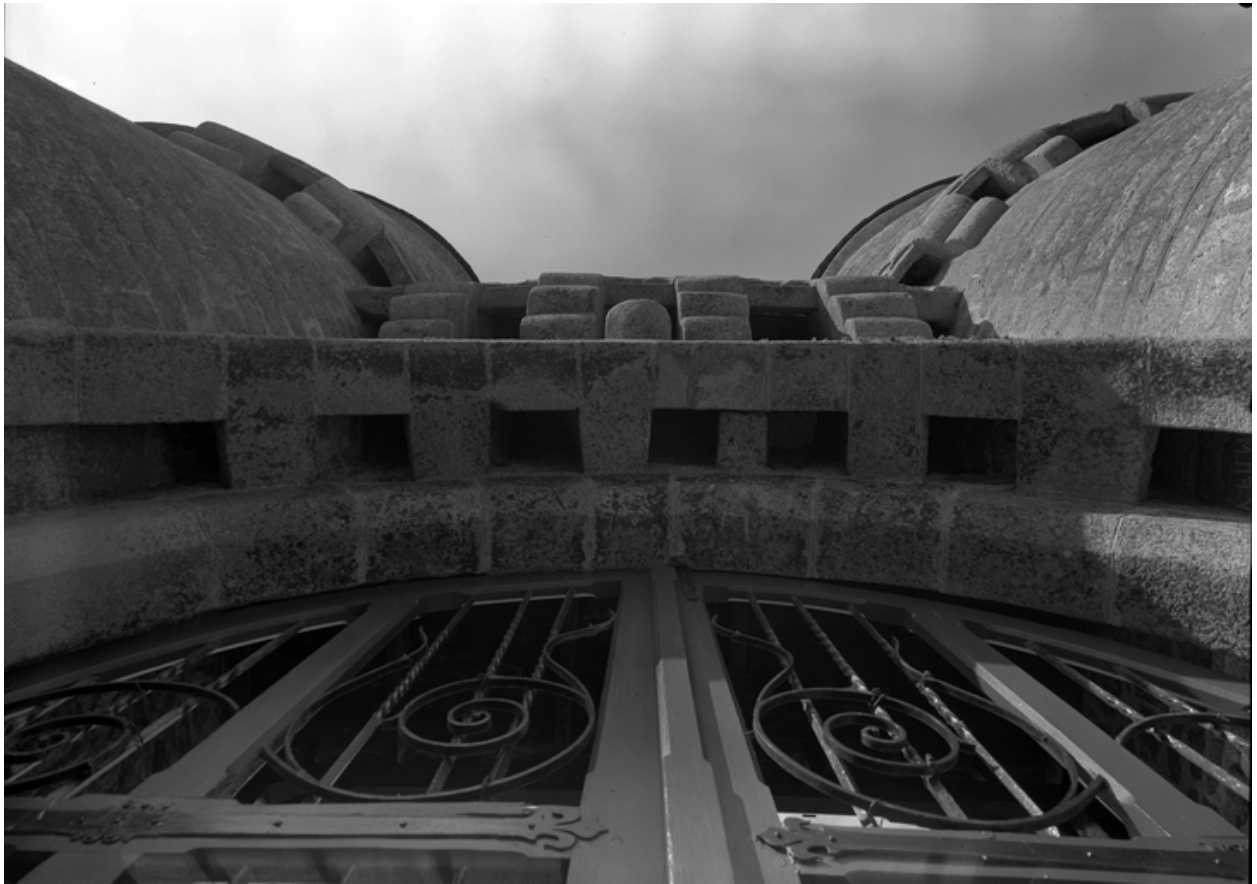
Châtelet, façade sud, détail, enquête de 1969
