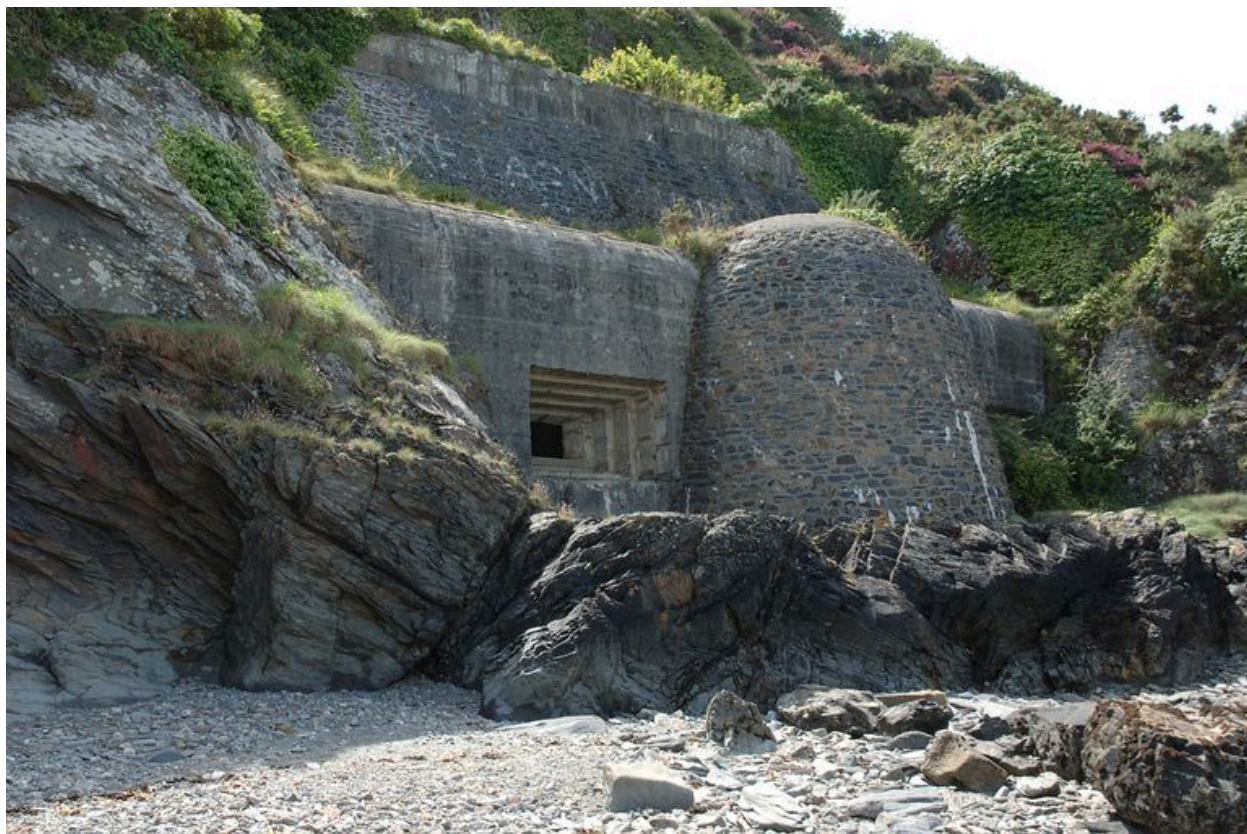
Vue des deux casemates en béton armé (état en 2006). Au centre, le massif en maçonnerie de la batterie casematée
