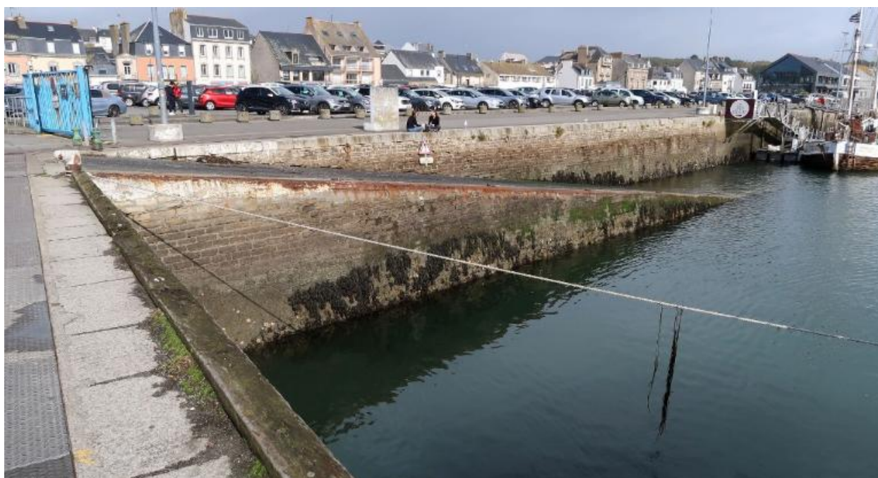
Cale du quai Carnot
