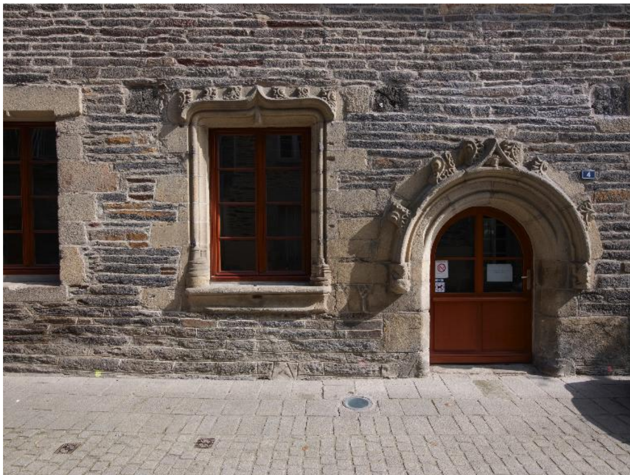
Maison, élévation antérieure, 1er niveau : porte et fenêtre gauche (état en 2012)
