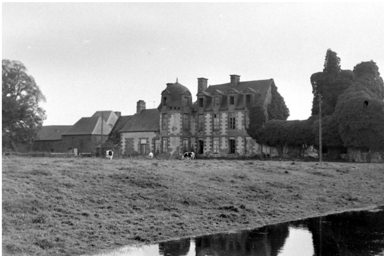
Vue générale de la façade vers le nord est
